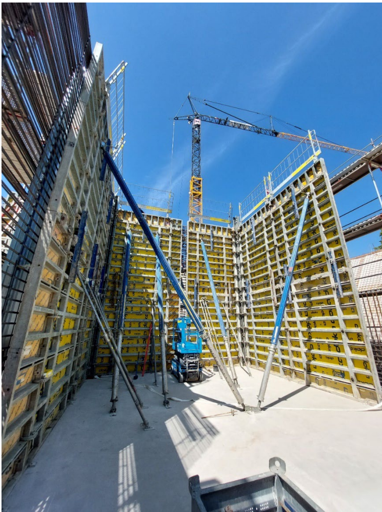
Auf dem Boden des Belebungsbeckens stehend mit Blick auf die Schalung der 7,5m hohen Wände
