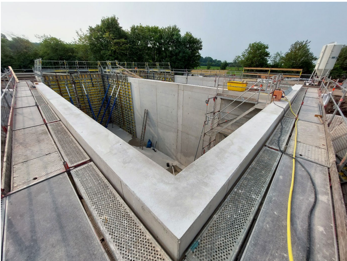
Fertig betonierte Nordwestecke des Belebungsbeckens mit Blick ins Becken; im Hintergrund die Schalung der Ostwand
