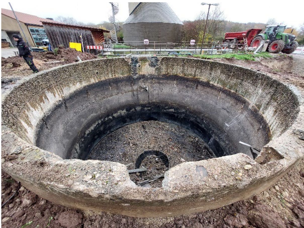
Entleerter Voreindicker vor dem Abbruch
