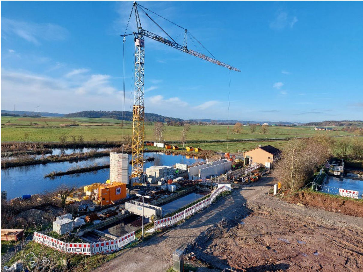
Blick auf den neuen Sandfang sowie das geräumte Baufeld für das neue Maschinengebäude im Vordergrund
